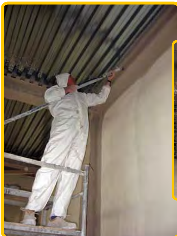
PROTEZIONI R.E.I. CON INTONACO A COPERTURA DI PILASTRI
